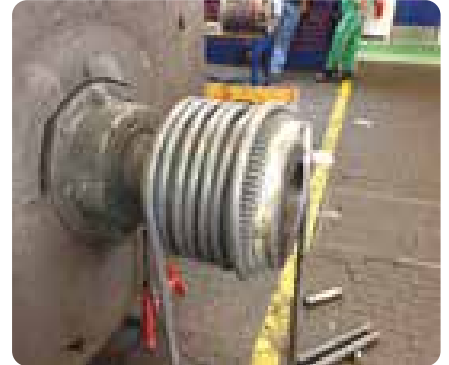
Chauffe d'un accouplement pour démontage
